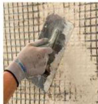
Ugradnja FRCM sustava
