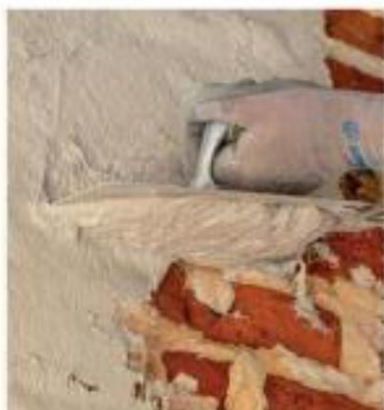
Žbukanje reparaturnim mortom
